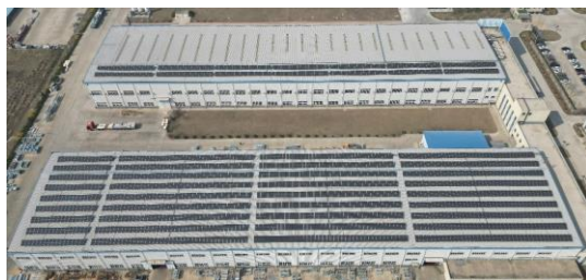
荏原冷熱システム（中国） 太陽光発電設備
