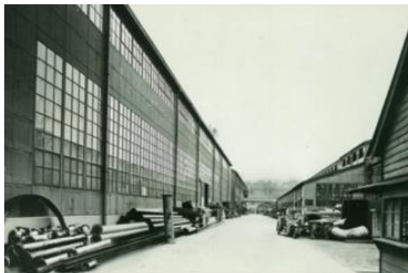
当時の主力工場である大崎工場
