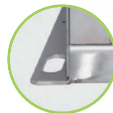
図3 ベースアンカ穴の長穴化
