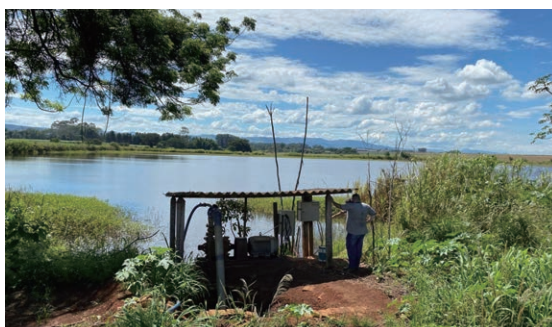
農場内の「ため池」から取水し、ポンプを用いて灌漑装置へ給水
