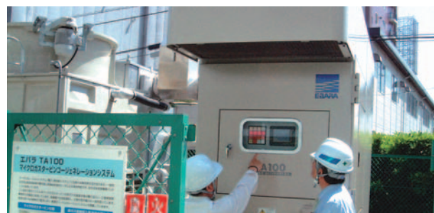
マイクロガスタービン設置工事審査
